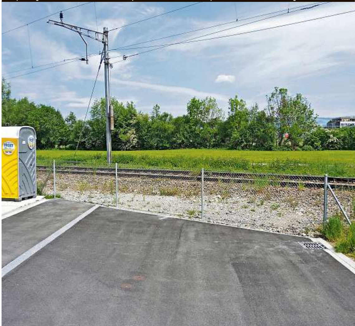
Fehlplanung oder Blick in die Zukunft: Im Feldpark endet die Strasse abrupt an den Gleisen der alten Zugschleife.
