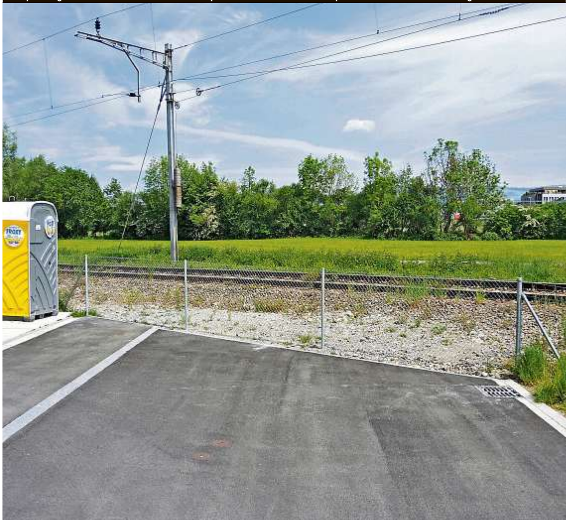
Fehlplanung oder Blick in die Zukunft: Im Feldpark endet die Strasse abrupt an den Gleisen der alten Zugschleife.
